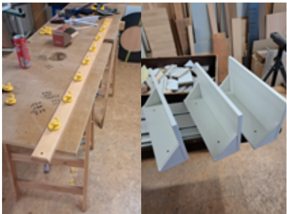
Construction modulaire Modulbau
